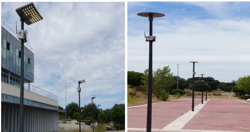
Figura 24. Farolas de bajo consumo instaladas en el Campus
