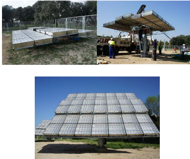
Figura 7. Planta piloto de concentración fotovoltaica: Módulos instalados en la parrilla del seguidor (superior izquierda), instalación de la parrilla con módulos en el soporte (Superior derecha) y seguidor instalado (inferior).
