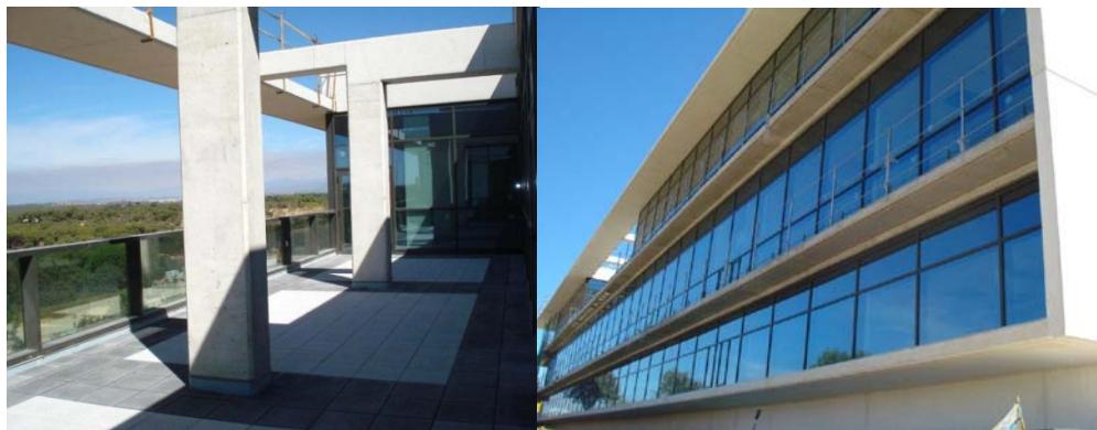
Figura 2. Edificio del CAIT y del CIESP
